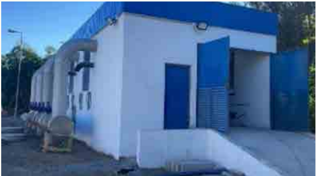
Ampliación de PTAS Curicó
