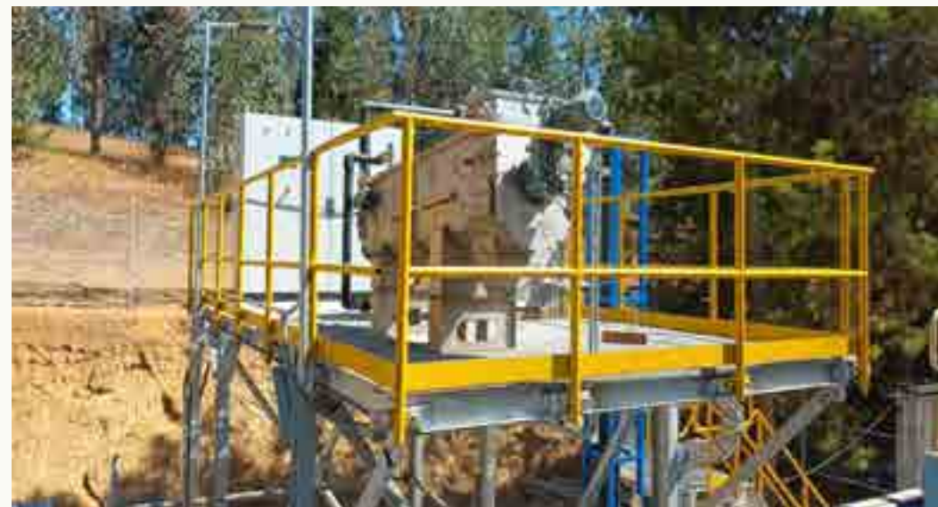
Ampliación de PTAS Curepto
