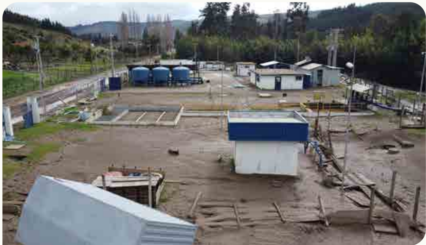
Inundaciones por emergencia climática Constitución. Planta producción de agua potable.
