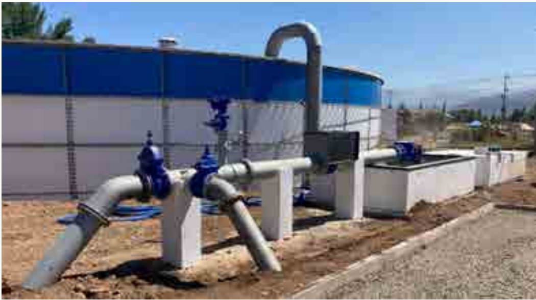
Construcción de 16 Nuevos Pozos con un Caudal total de Q= 477 L/s
