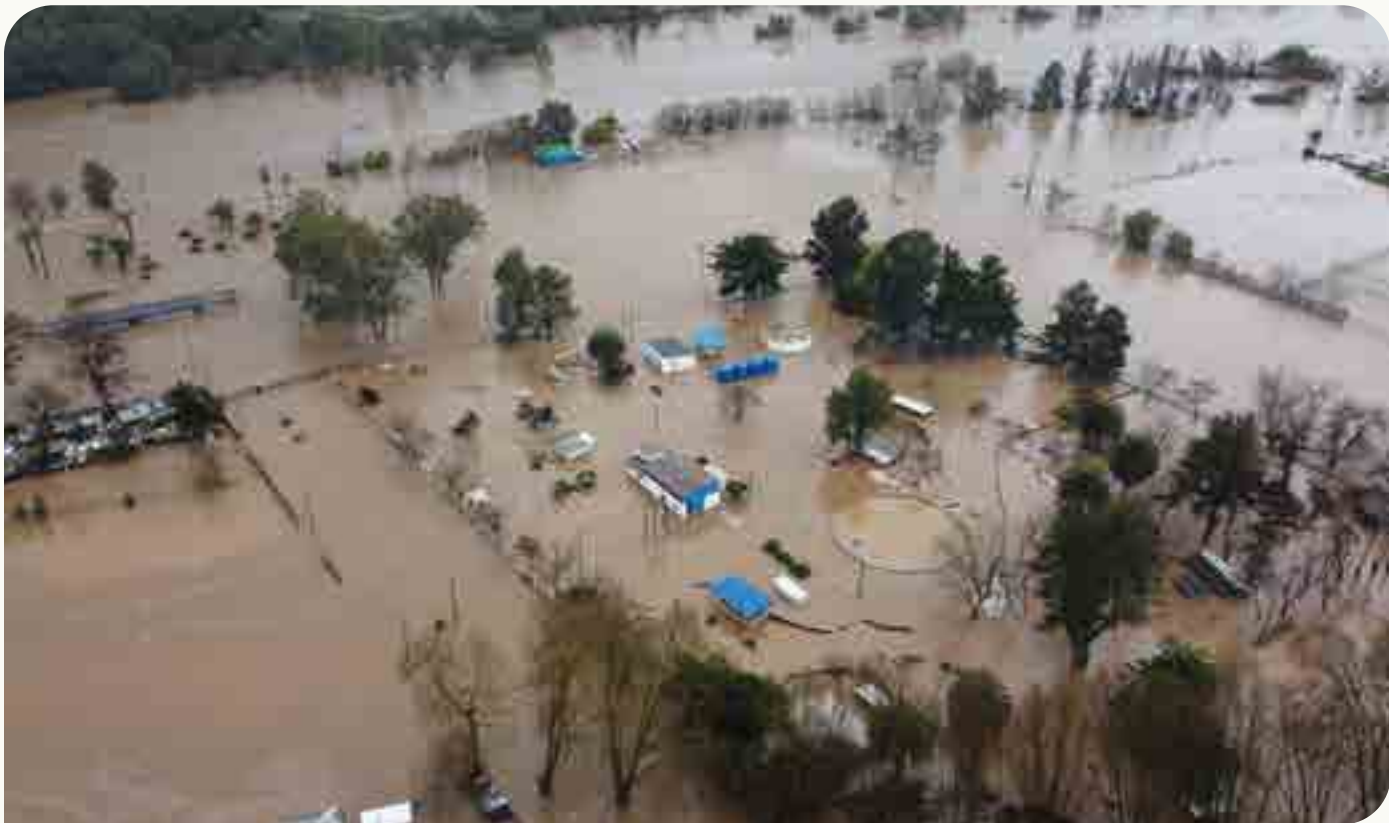
Inundaciones emergencia climática rio Claro 2023. Planta de producción de agua potable.
