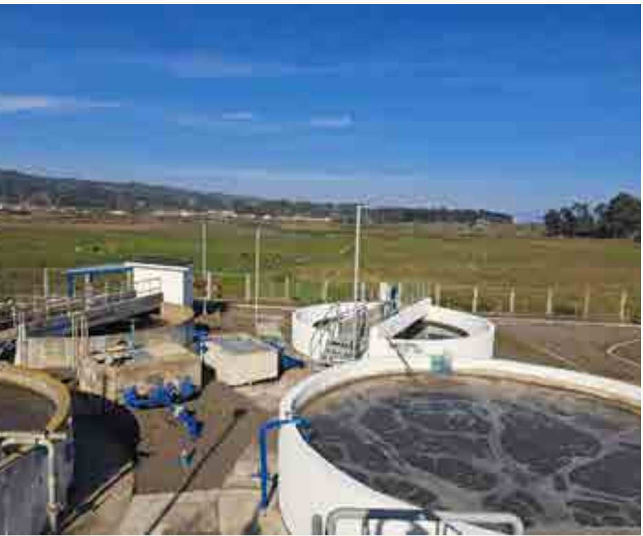
Ampliación de PTAS Cobquecura
