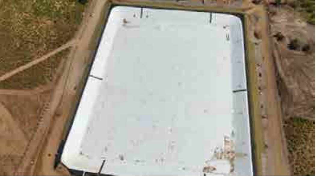
Construcción Tranque Lonquén Ninhue Volumen 40.000 m 3
