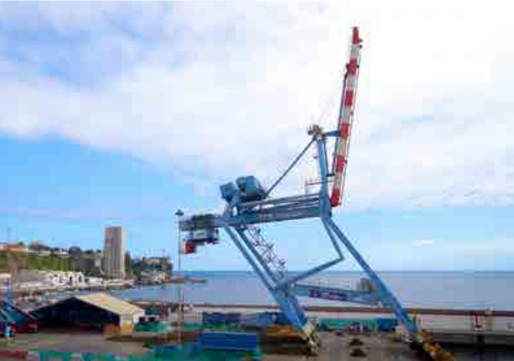
Colapso controlado grúa pórtico 1.
