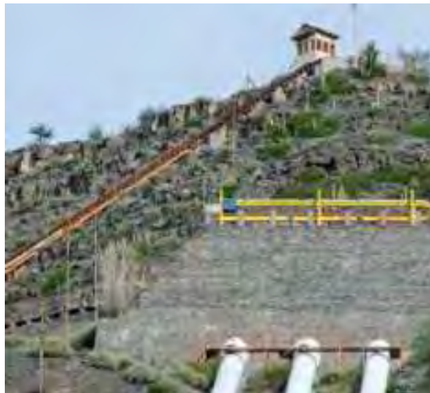
1923, entra en operación la Central Hidroeléctrica Maitenes en San José de Maipo
