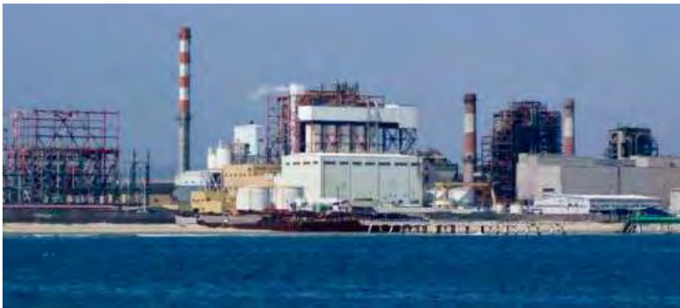
Central Termoeléctrica Ventanas IV
