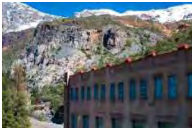
Central Hidroeléctrica Queltehues en San José de Maipo
