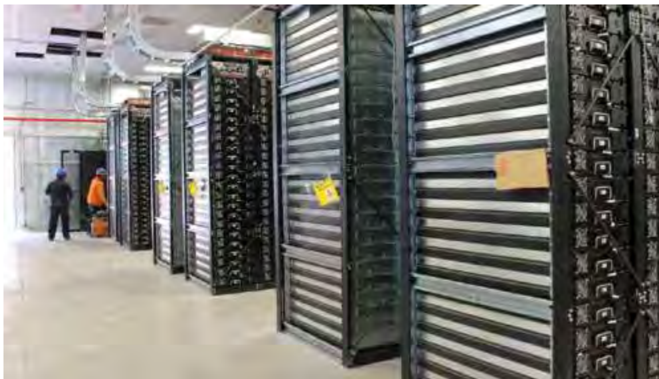
Virtual Reservoir, el primer sistema de almacenamiento de energía del mundo, integrado a una central hidroeléctrica de pasada.
