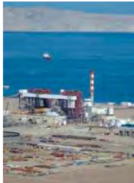
Central Termoeléctrica Angamos
