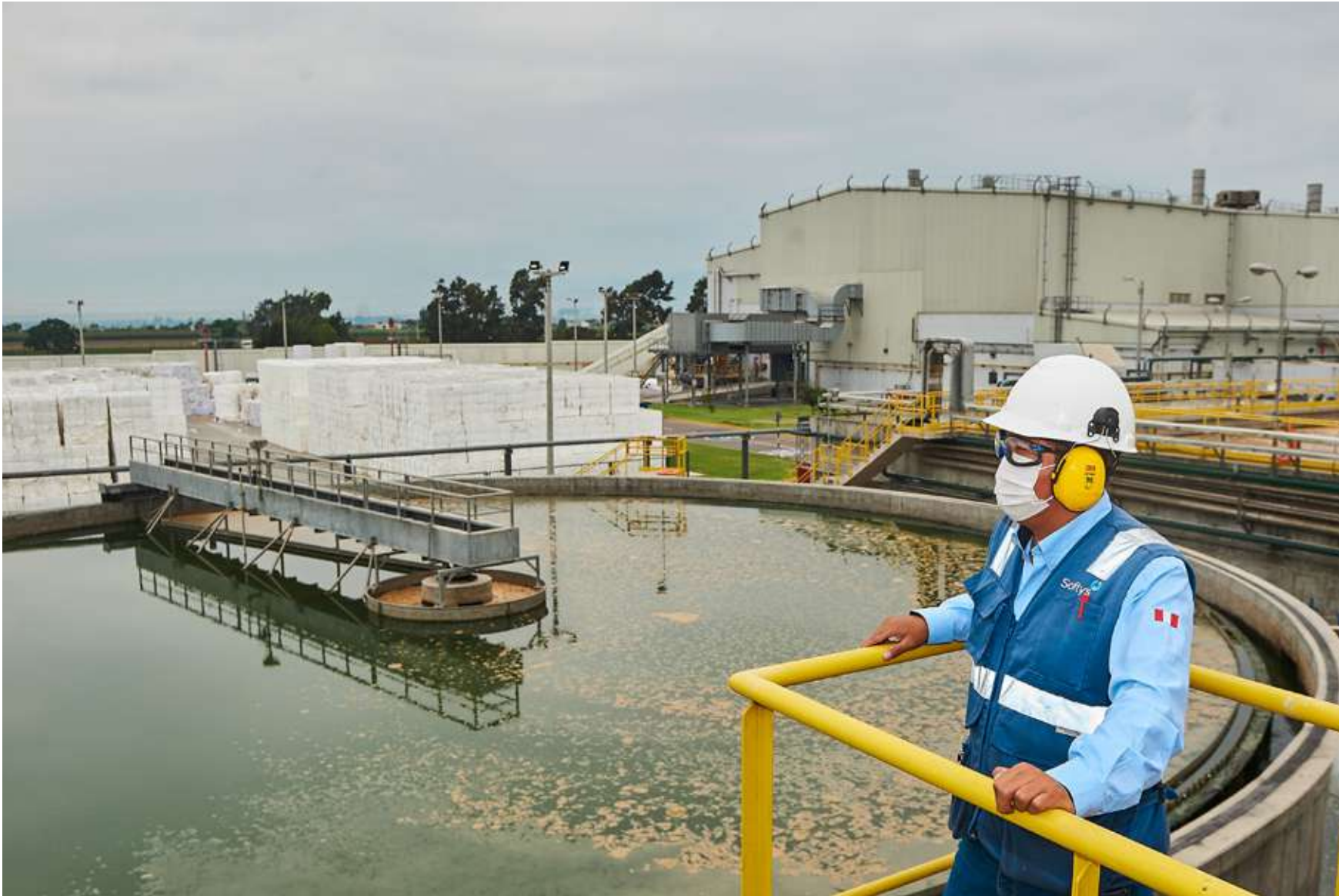
Planta de tratamiento de efluentes, en planta Cañete, Perú.
