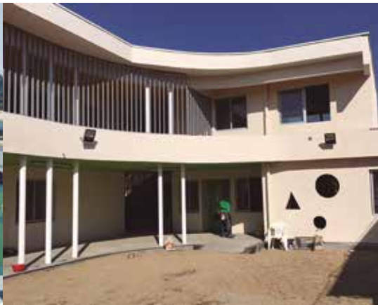
Jardín Infantil San Ramón (En Construcción) Jardín Infantil San Ramón (in construction)
